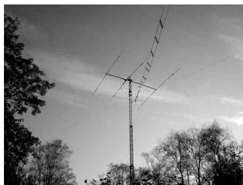
och vidare upp till masttoppen där 2x20 m dubbelzepp sitter:
