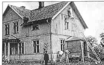
Bilden till vänster är från 1970. Då var det minst sagt fallfärdigt. Byte av rutten panel, trasiga fönster fick göras innan målning kunde ske. Bilden till höger är nytagen och i ett mycket bättre skick. Foto: PRIVAT
